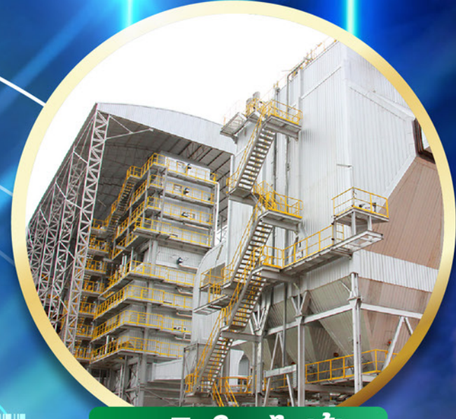
ธุรกิจโรงไฟฟ้า
