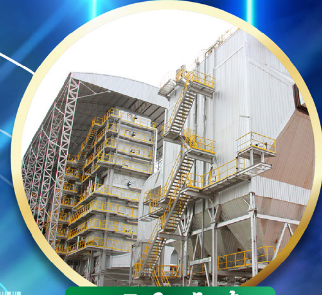
ธุรกิจโรงไฟฟ้า
