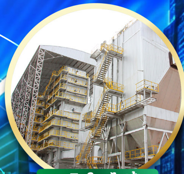
ธุรกิจโรงไฟฟ้า
