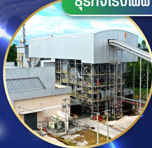
ธุรกิจโรงไฟฟ้า
