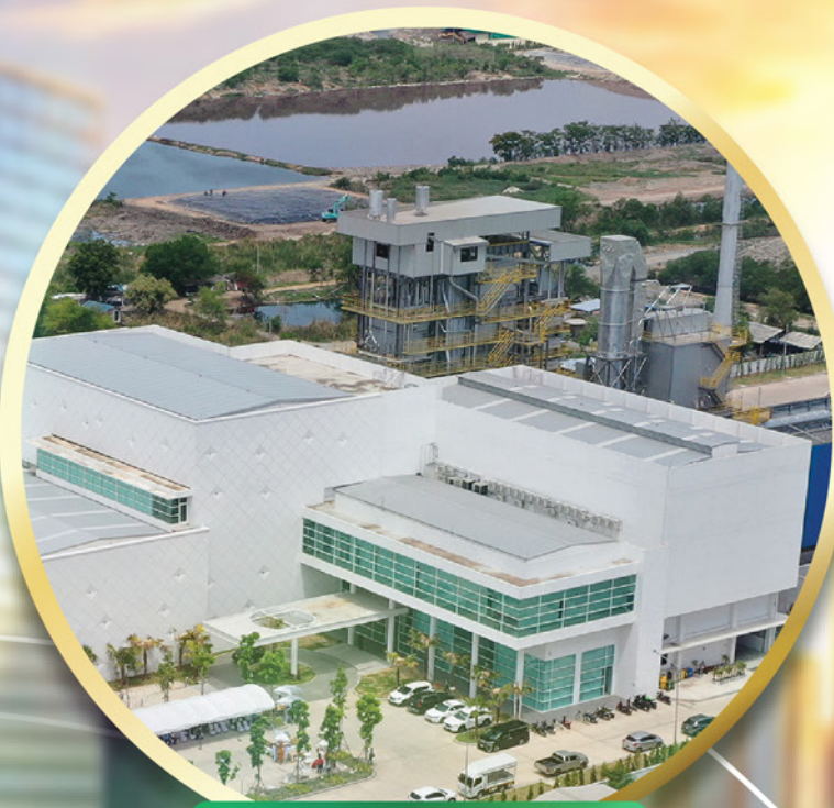
ธุรกิจโรงไฟฟ้า
