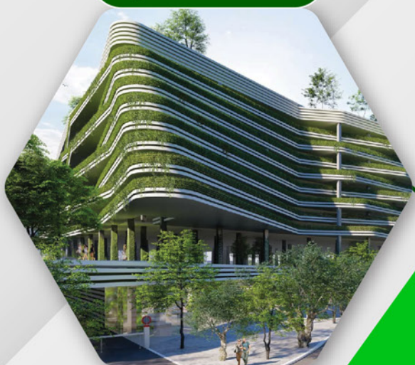
ธุรกิจก่อสร้าง
