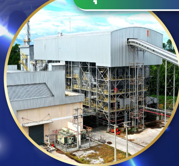
ธุรกิจโรงไฟฟ้า
