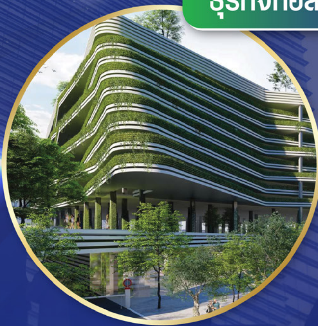
ธุรกิจก่อสร้าง
