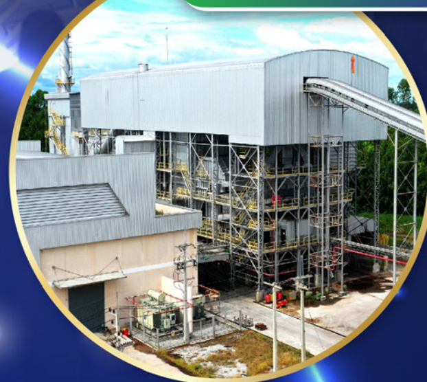
ธุรกิจโรงไฟฟ้า
