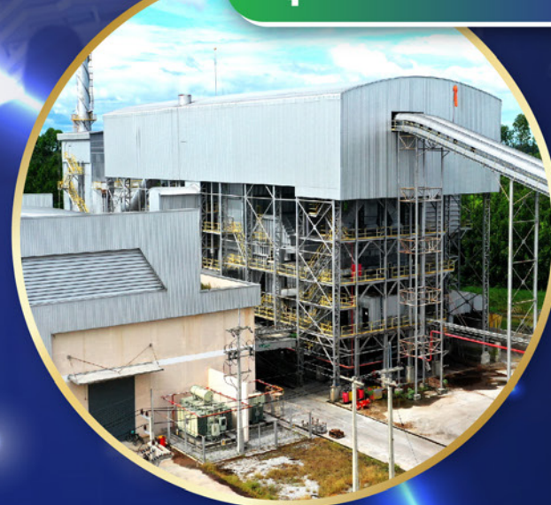
ธุรกิจโรงไฟฟ้า
