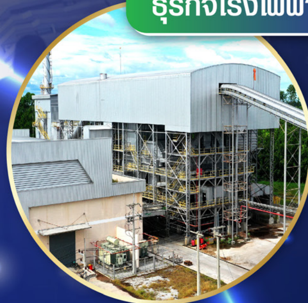
ธุรกิจโรงไฟฟ้า
