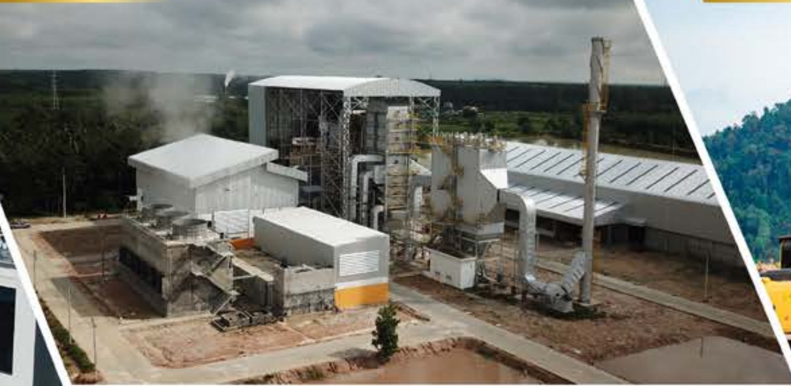
ธุรกิจโรงไฟฟ้า
